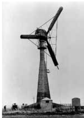
De Gedser windturbine uit 1957. De wieken waren gemaakt van hout, staal en aluminium, verstevigd met een structuur van staalraad.
