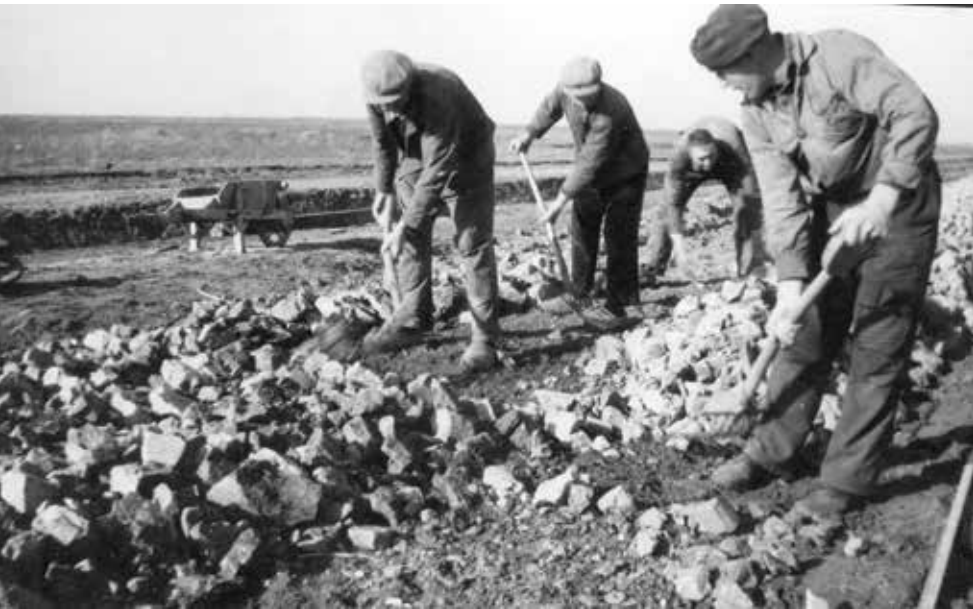
Vier arbeiders egaliseren het puin voor de fundering van een weg.
