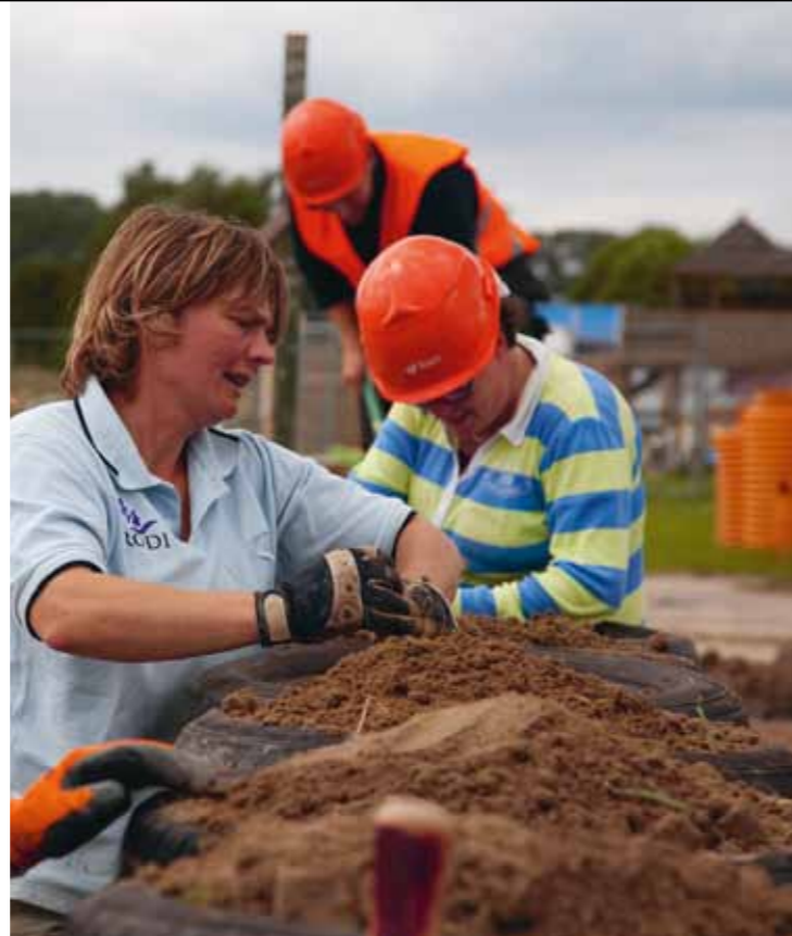
De bouwers werken met het principe van superuse : afval, zoals autobanden, wordt direct gebruikt als hoogwaardig bouw materiaal.
